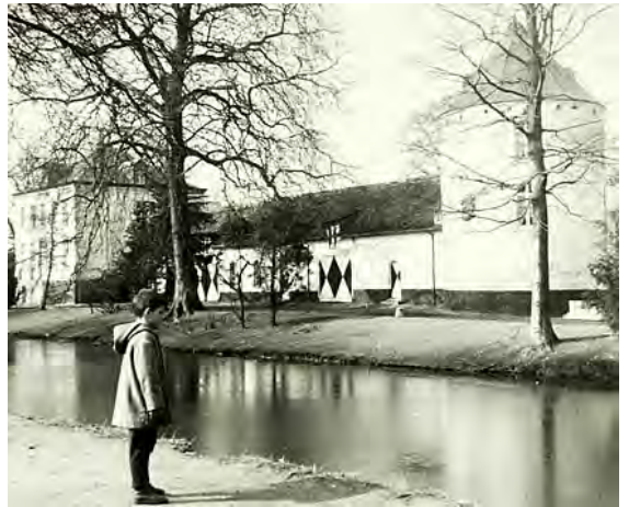
Afb. 8. Het nieuwe kasteel te Weert tegenwoordig. Links het 19de-eeuwse woonhuis dat op de nog intact zijnde kanonkelder van de donjon werd gebouwd. Rechts de oostelijke hoektoren, in de 19de eeuw met een verdieping verhoogd, met de ingemetselde steen waarop het wapen van Horne en het Gulden Vliesattribuut. (Foto van de schrijver).
